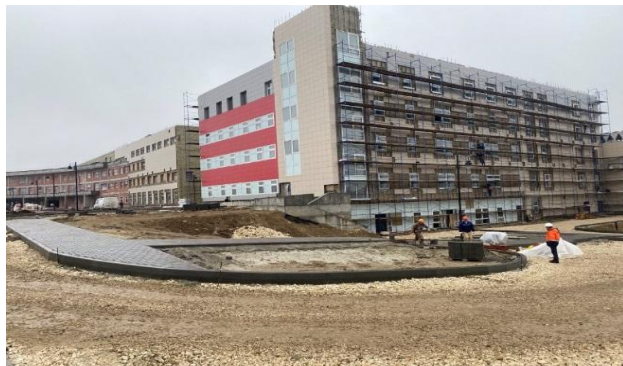
Монтаж фасада корпуса операционной и реанимации
