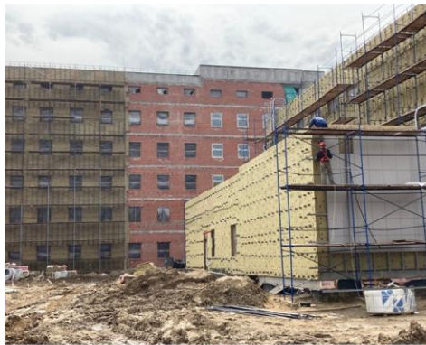
Монтаж фасада корпуса операционной и реанимации
